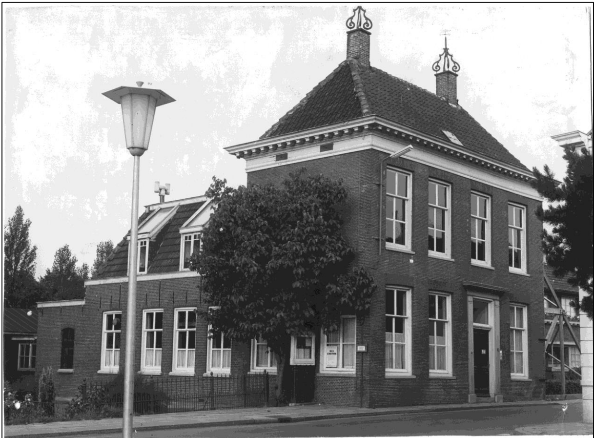
Figuur 6: Foto van Dorpsstraat 3 uit 1957 (foto richting het zuidwesten).
